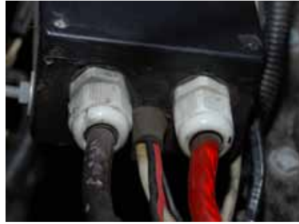
ORDENTLIGA KABELGENOMFÖRINGAR MÅSTE ANVÄNDAS FÖR ALLT KABLAGE
